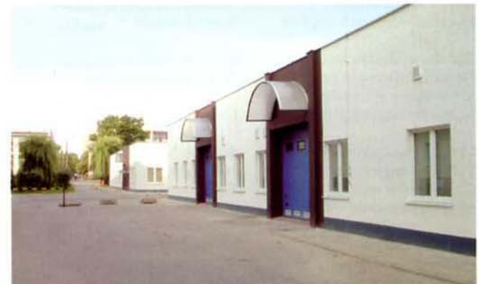
Nowe hale laboratoryjne przy ulicy Kórnickiej
